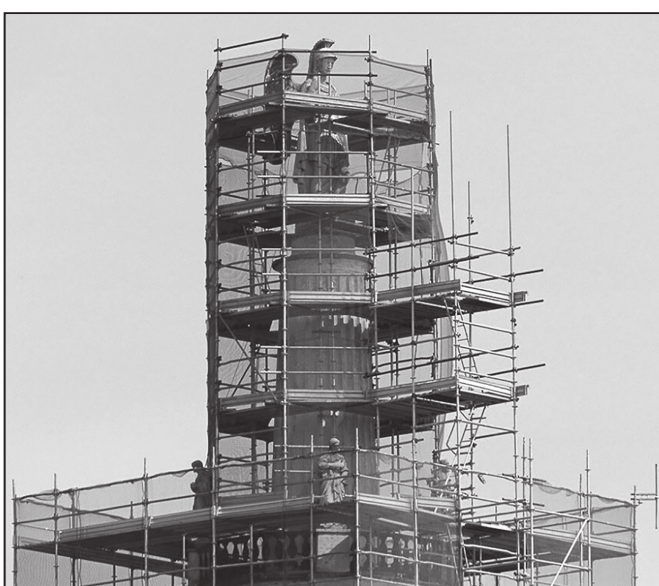
Il campanile con l'impalcature per i lavori di restauro
